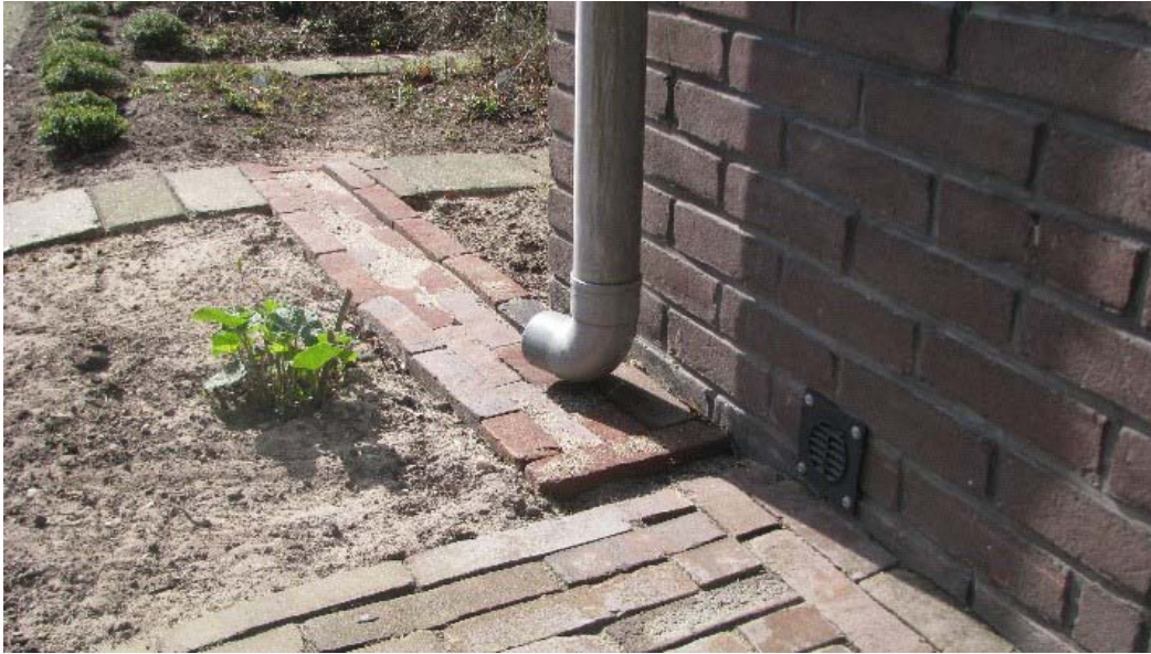
Figuur 6: Voorbeeld van een afgekoppelde regenpijp. Deze voert nu af naar de tuin. Bron: https://amersfoortduurzaam.nl/water+en+groen/dit+kun+je+zelf+doen+water+en+groen/1457576.aspx
